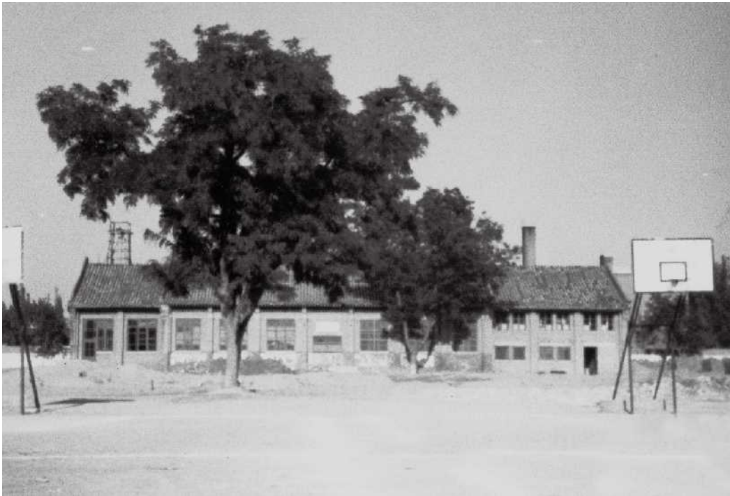
【完成した体育館全景】
