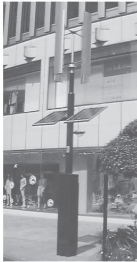
図6 街灯などに利用されているハイブリッド発電システム（東京都千代田区有楽町）
